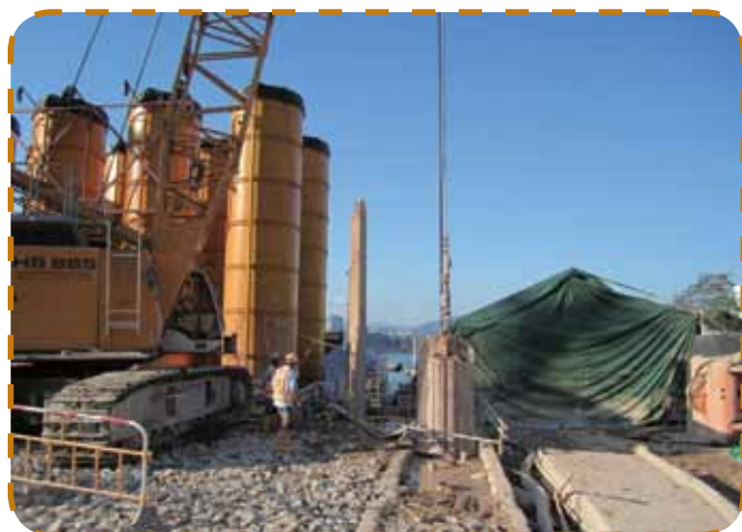
隧道隔牆建造工程 Construction of diaphragm wall
