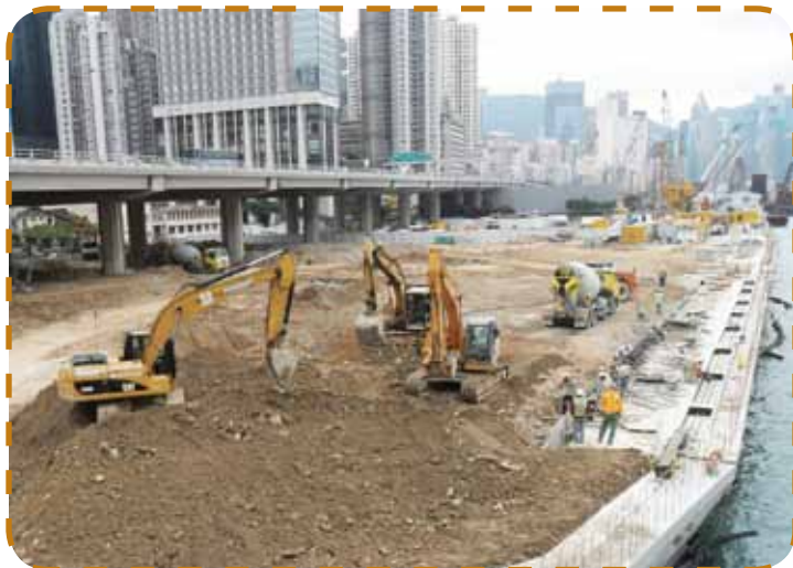
填海工程 Reclamation works
