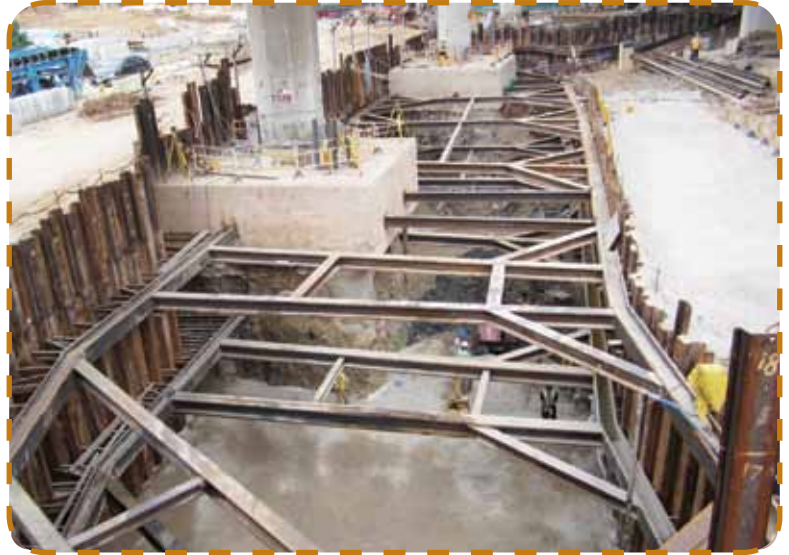
食環署地下停車場的挖掘工程 Excavation works for the FEHD basement car park
