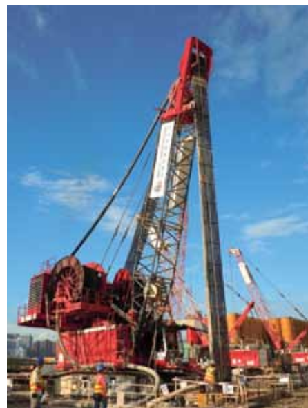
溝道切割機 Trench Cutter
